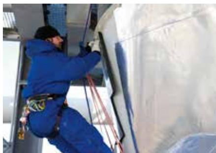
**Bild 3: Bei der Dämmung von Behältern mit vorbeschichteten Elastomerdämmstoffen kann i.d.R. auf eine Unterkonstruktion verzichtet werden** (Bild: Armacell)
