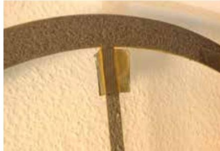
**Bild 1: Davon wird abgeraten: Kammprofildichtung zur Montage mit Klebeband befestigt**
