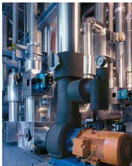
**Bild 1:** In der Pharma-, Chemie- und Lebensmittelindustrie, insbesondere in Reinräumen oder Bereichen mit hohen Hygiene-Anforderungen, minimieren halogenfreie Dämmstoffe auf Edelstählleitungen das Risiko der Spannungsrisskorrosion (Bild: Armacell GmbH)
