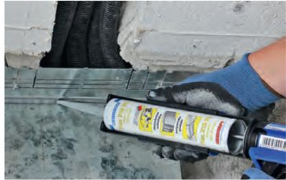
**Bild 3: PU-Klebstoffe wie Flex 310 PU sind dauerelastisch und haftstark und zeigen eine hohe elastische Verformbarkeit** (Bild: WEICON GmbH & Co. KG)
